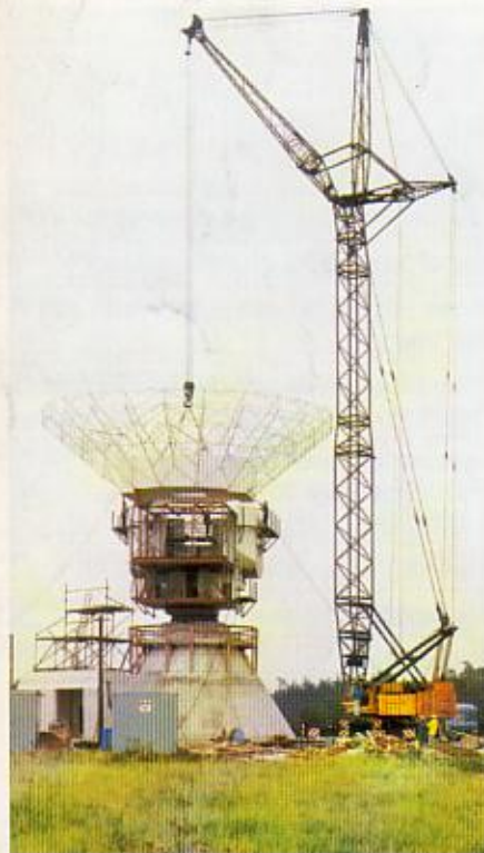
GOTTWALD AK 210-73 mit 180/210 t Tragfähigkeit
