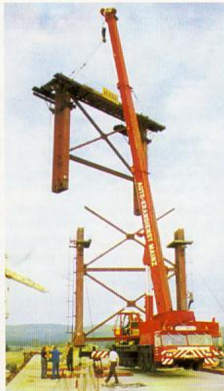
GOTTWALD AMK 126-63 mit 125/143 t Tragfähigkeit
