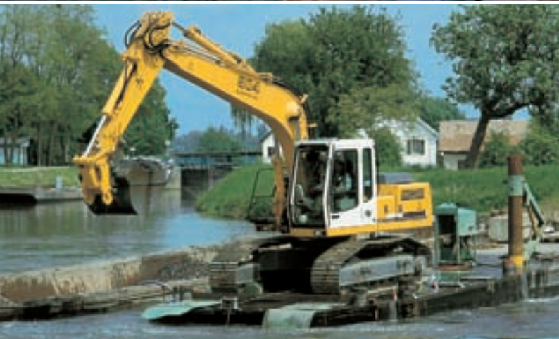
Tieflöffel im Wasserbaueinsatz
