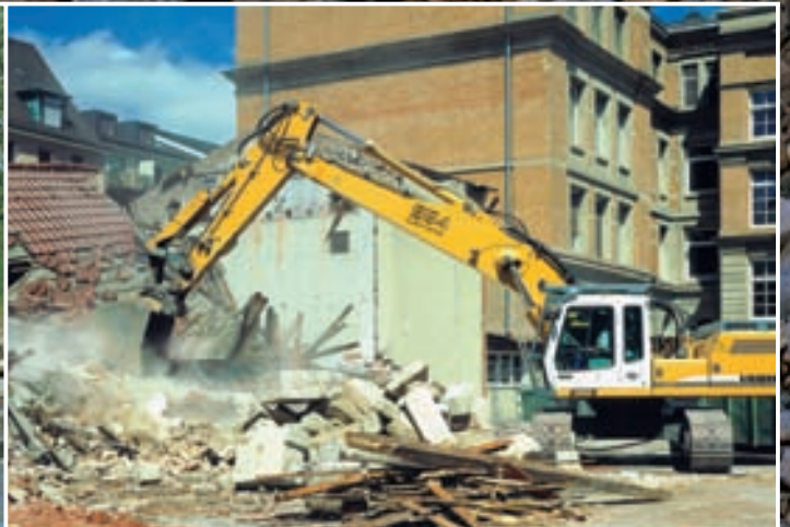
Tieflöffel beim Abbrucheinsatz
