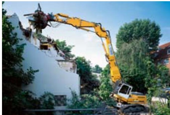
Die Abbrucharbeiten werden mit einem 1,5 m<sup>3</sup> fassenden Sortiergreifer als Arbeitsgerät durchgeführt. Eine sehr gute Sicht auf sein Arbeitsfeld bietet dem Fahrer die bis zu 30° nach oben kippbare Abbruchkabine. Diese Spezialkabine ist mit einem stabilem Steinschlagschutz sowie Panzerglas in der Frontscheibe und im großen Dachfenster ausgestattet.
