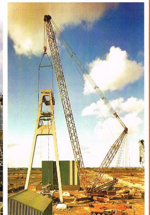
GOTTWALD AK 680, 650/850 t Tragfähigkeit
