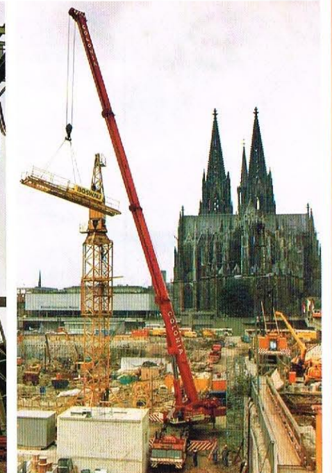
GOTTWALD AMK 200-83, 200/230 t Tragfähigkeit
