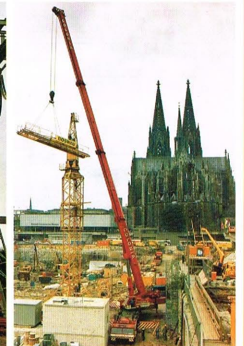
GOTTWALD AMK 200-83, 200/230 t Tragfähigkeit
