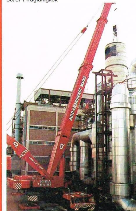
GOTTWALD AMK 400-93, 400/500 t Tragfähigkeit
