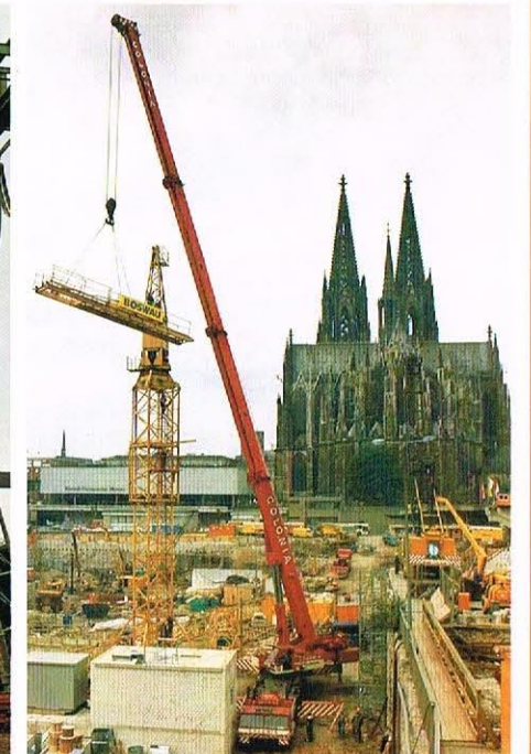
GOTTWALD AMK 200-83, 200/230 t Tragfähigkeit
