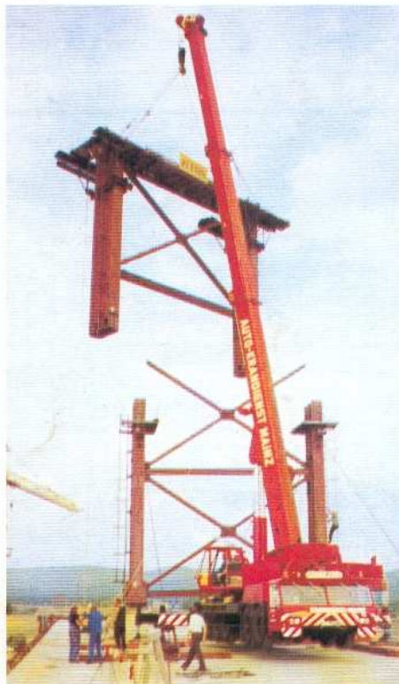
GOTTWALD AMK 126-63 mit 125/142 t Tragfähigkeit
