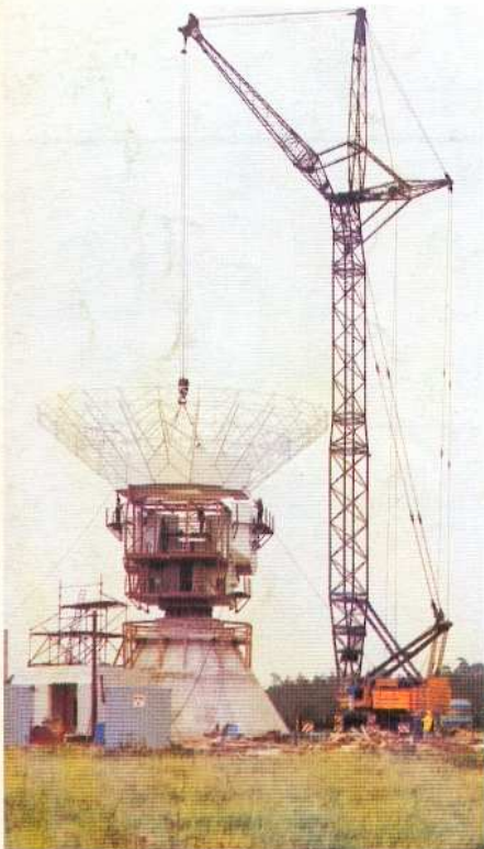
GOTTWALD AK 210-73 mit 180/210 t Tragfähigkeit
