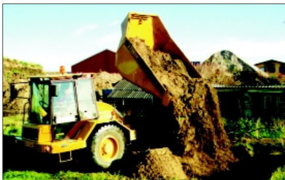
Dumperlad drejes og tippes i én arbejdsgang.
