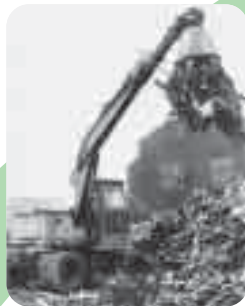
1965 Hydraulischer Bagger im Schrottschlag Hydraulic excavator in scrap handling
