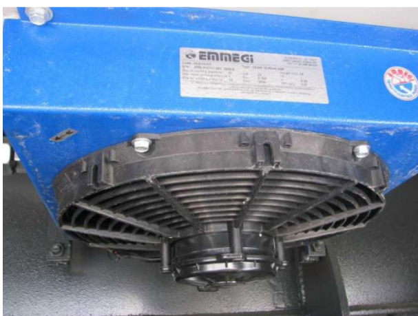
Podwójna chłodnica oleju, utrzymująca jego stałą temperaturę.
