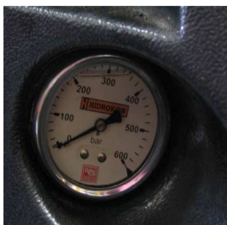
Czujniki ciśnienia oleju hydraulicznego w kabinie operatora.
